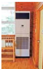
屋外ログハウスの エアコンを取り換え
