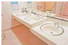
トイレの手洗い場に 自動水栓を設置
