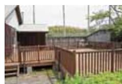
屋外ログハウスの ウッドデッキ修繕
